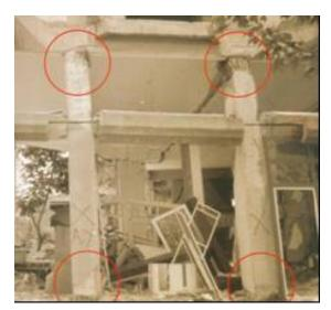
Picture 3. Problems at the points of connection of beam end and a column (Resim 3. Kolon-kiriş birleşim noktalarında problemler)
